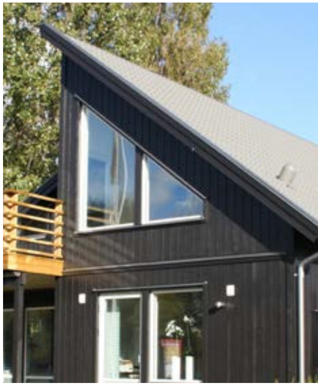
Dubbel vindskiva med vindskiveplåt
