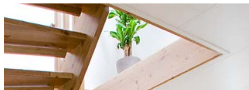
Inklädnaden av öppningen bör utföras och planeras samtidigt med trappan. Dels påverkar inklädnaden öppningsmått, dels kan den tillverkas så att den matchar trappan. Tillval.
