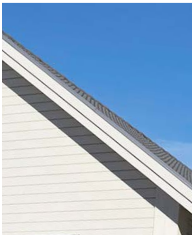
Dubbel vindskiva med vindskiveplåt
