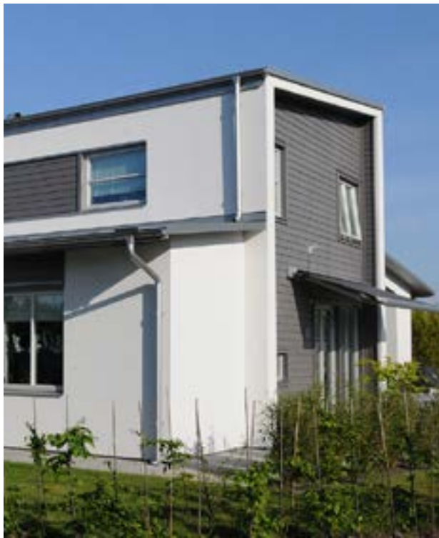
Vindskiveutförande vid falsad plåt som takbeklädnad
