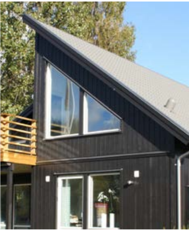
Dubbel vindskiva med vindskiveplåt
