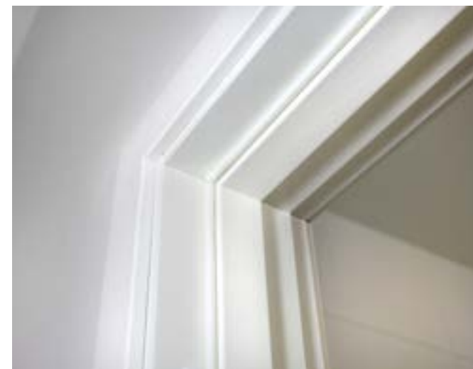
Förmonterad tätningslist för ljuddämpning
