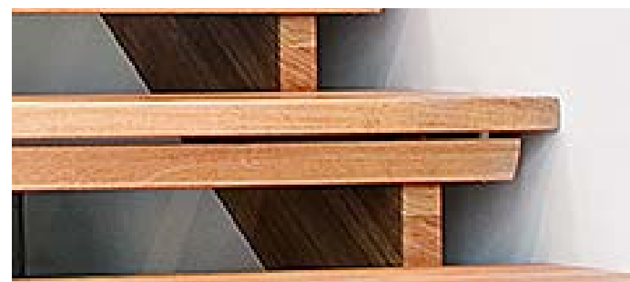
I en öppen trappa monteras en list under varje plansteg för att förhindra att barn kan tränga sig igenom och fastna.
