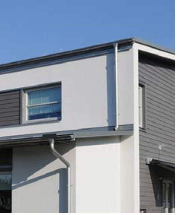
Vindskiveutförande vid falsad plåt som takbeklädnad
