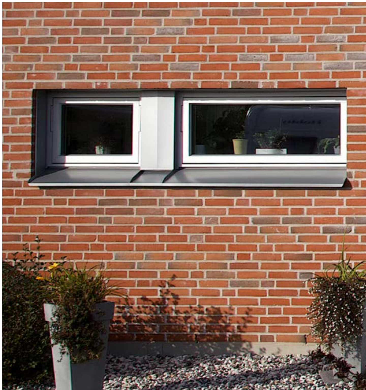
Infattning fönster vid tegelfasad.
