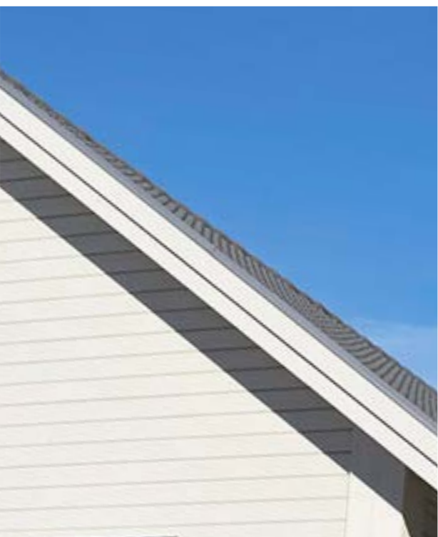
Dubbel vindskiva med vindskiveplåt
