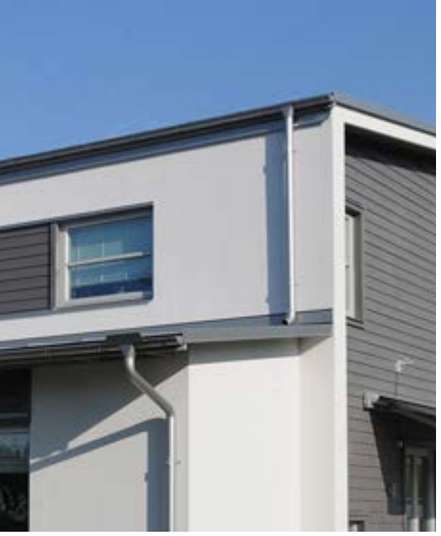
Vindskiveutförande vid falsad plåt som takbeklädnad
