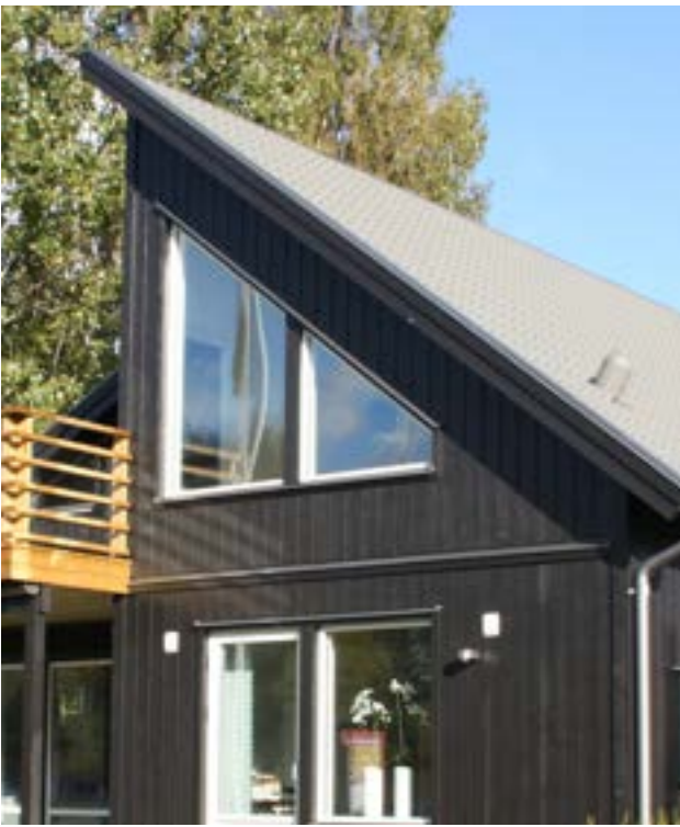
Dubbel vindskiva med vindskiveplåt
