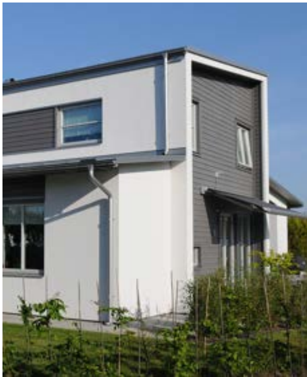
Vindskiveutförande vid falsad plåt som takbeklädnad
