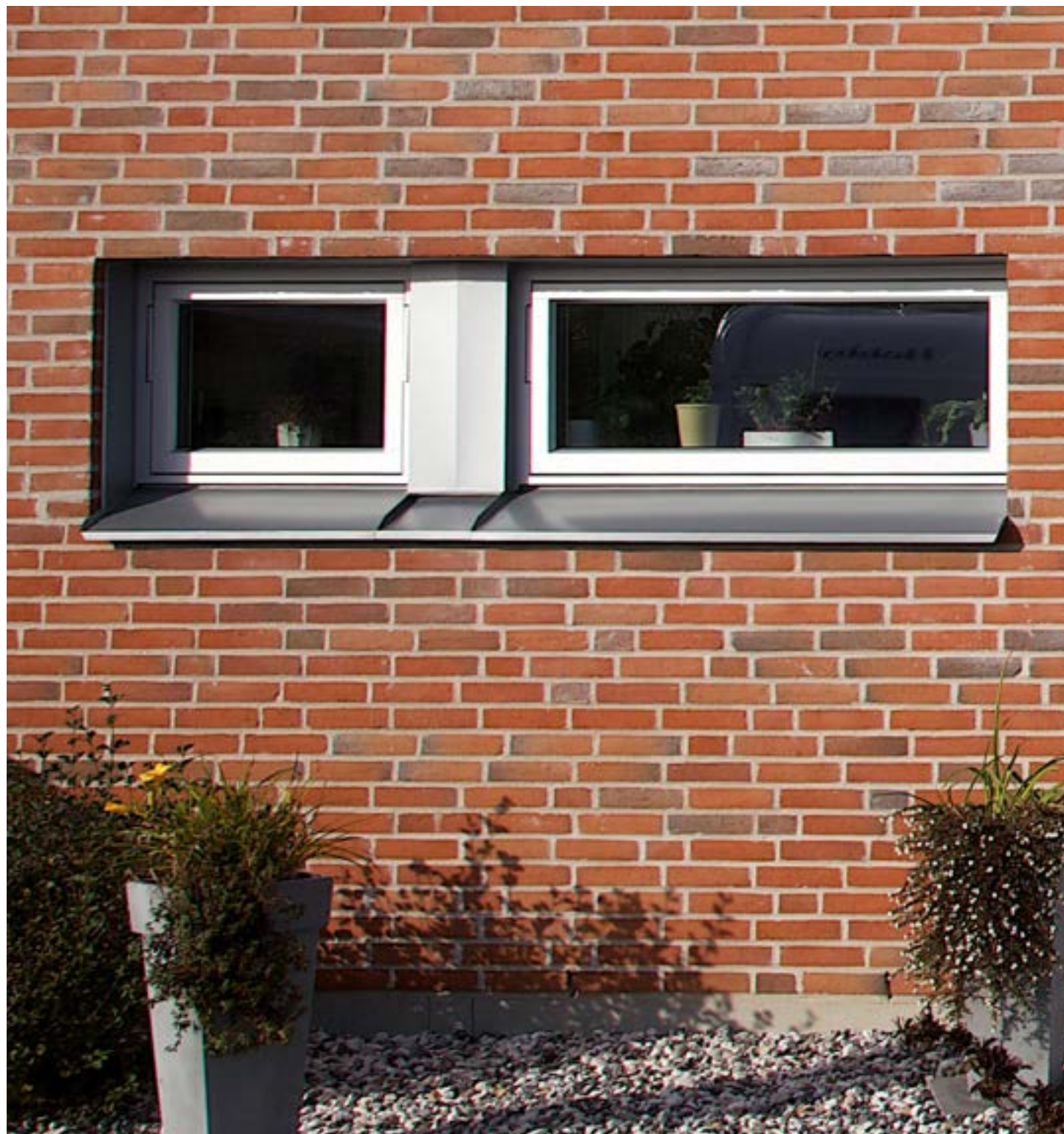
Infattning fönster vid tegelfasad.
