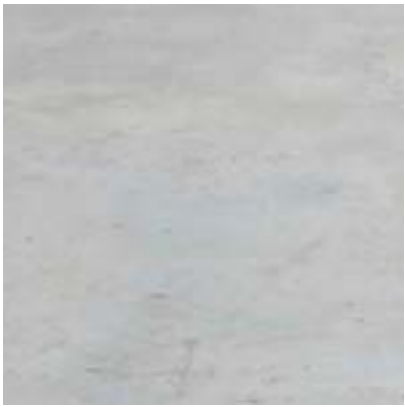
Vit Rå Betong
