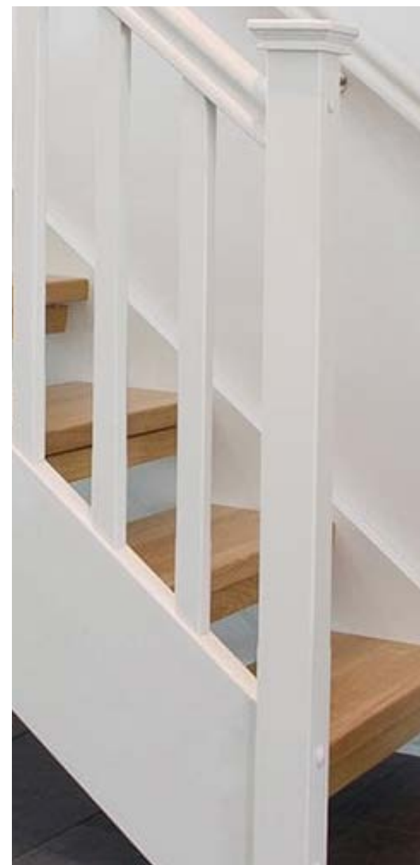
MountIn® är en patententerad lösning som gör trappor med sidoliggande vangstycken vackrare tack vare släta utsidor utan täckpluggar.
