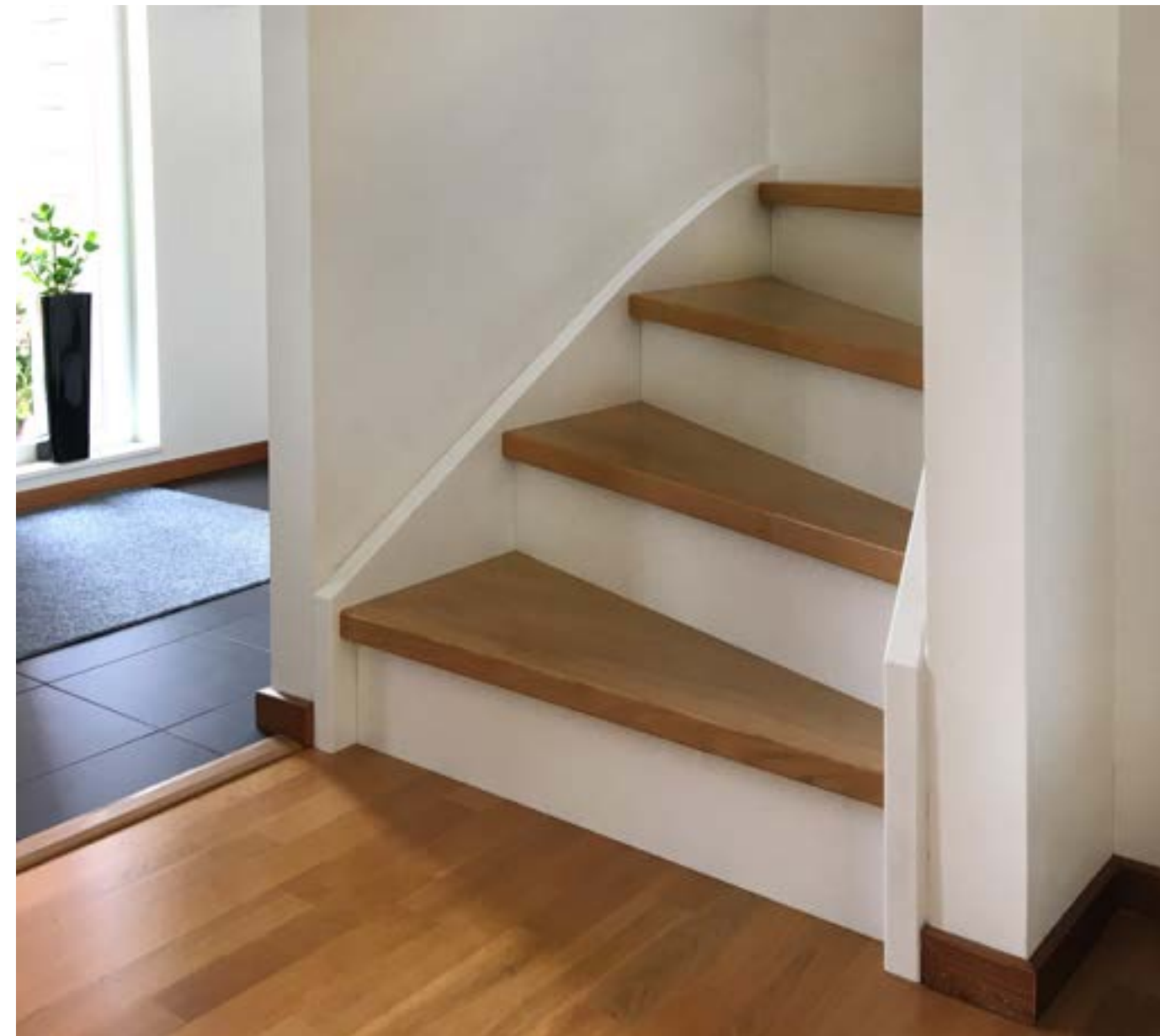
Inbyggd trappa är standard där ritning så visar. Det är ett populärt och smart alternativ är att placera en klädkammare eller ett skafferi under den inbyggda trappan. Plansteg i ek, sättsteg i vitt.
