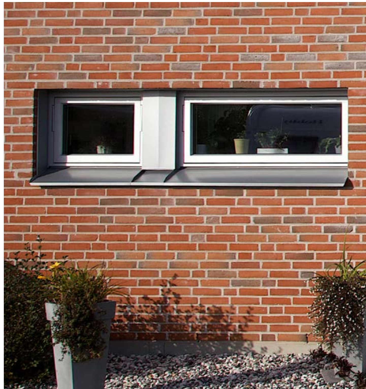
Infattning fönster vid tegelfasad.
