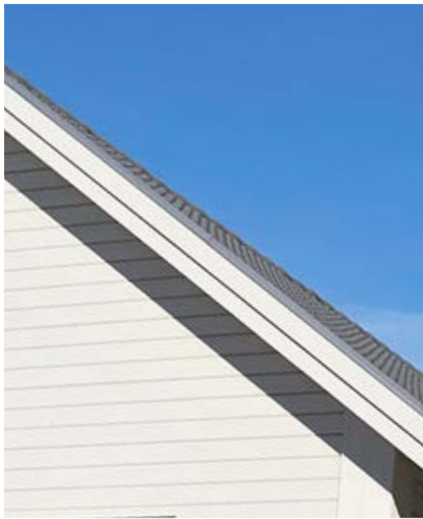
Dubbel vindskiva med vindskiveplåt
