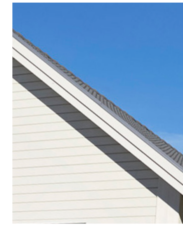
Dubbel vindskiva med vindskiveplåt
