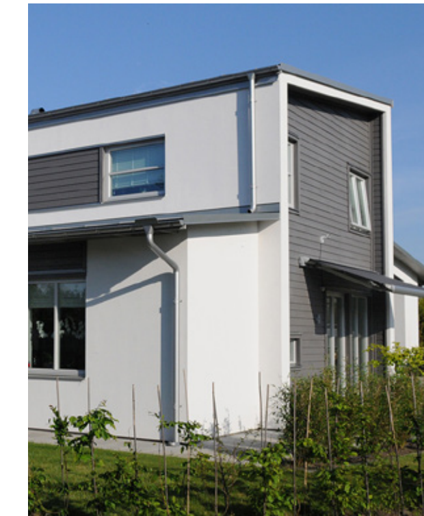
Vindskiveutförande vid falsad plåt som takbeklädnad
