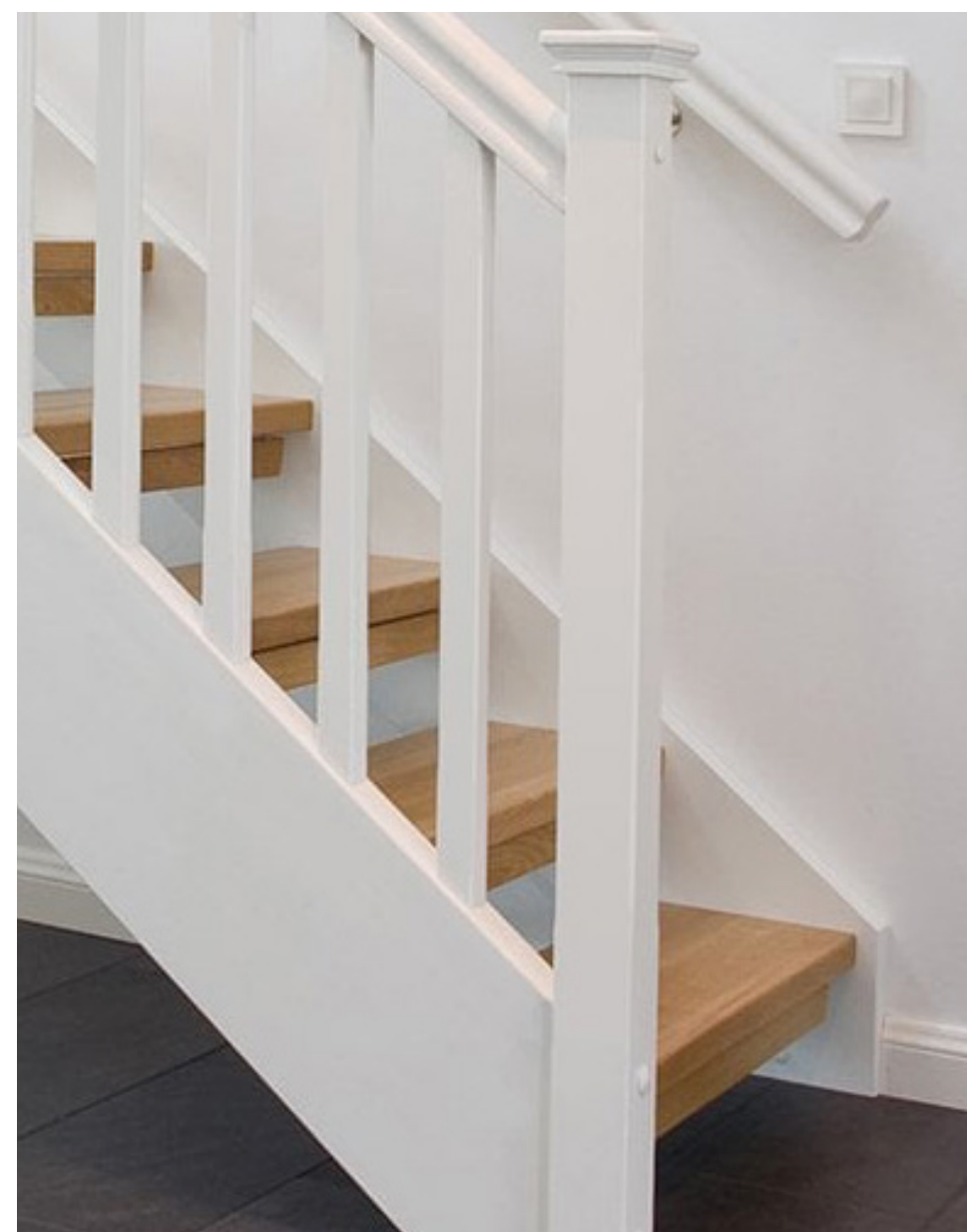
Dold infästning som gör trappor med sidoliggande vagnstycken vackrare tack vare släta utsidor utan täckpluggar.
