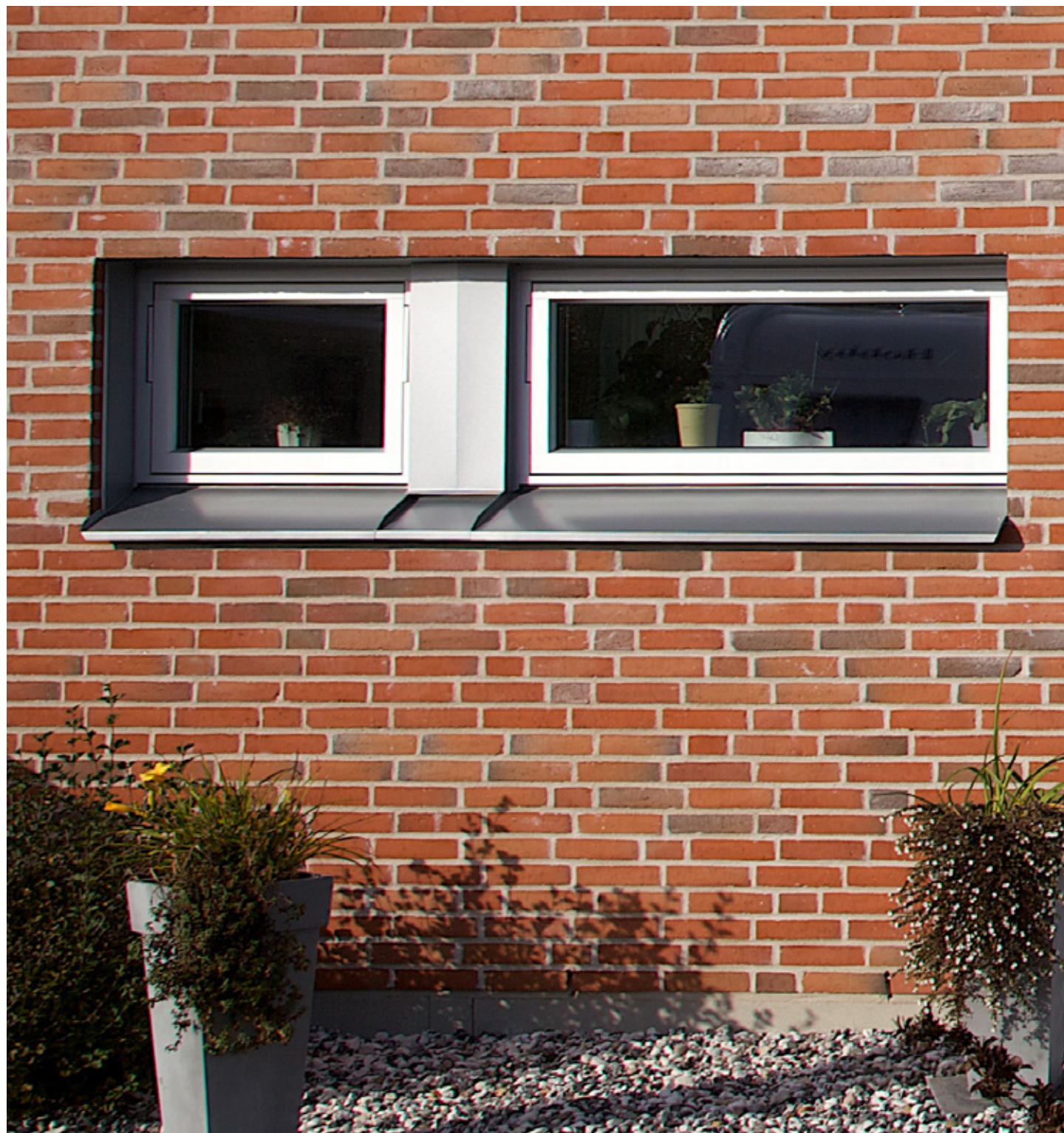
Infattning fönster vid tegelfasad.
